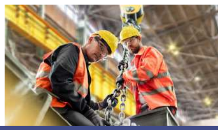
ИЗГОТОВЛЕНИЕ И МОНТАЖ МЕТАЛЛОКОНСТРУКЦИЙ
